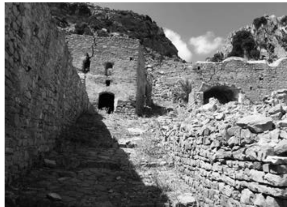
Fig. 2. Stradina di collegamento
